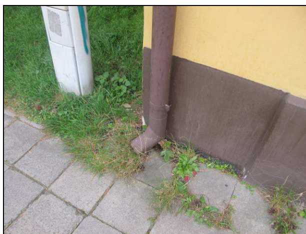
Foto č.16 – dešťový svod bez lapače splavenin, vyústění na uliční chodník
