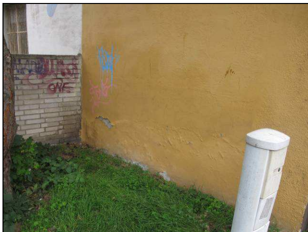
Foto č.17 – pohled na boční stěnu s vlhkostními projevy a viditelnou degradací omítkového systému
