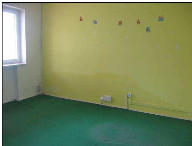
Foto č.20 – viditelné vlhkostní projevy na obvodové zdi v 1.NP
