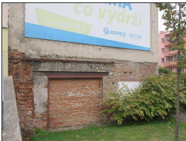
Foto č.3 – pohled na zadní stranu budovy – zazdění vjezdu
