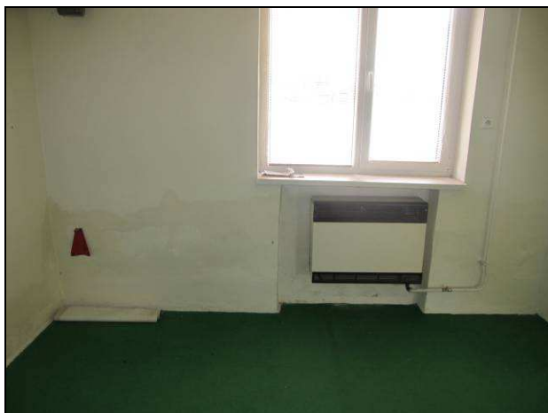
Foto č.19 – vlhkostní projevy na části obvodové zdi v 1.NP
