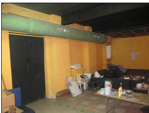
Foto č.9 – nefunkční vzduchotechnické potrubí po celé délce sálu
