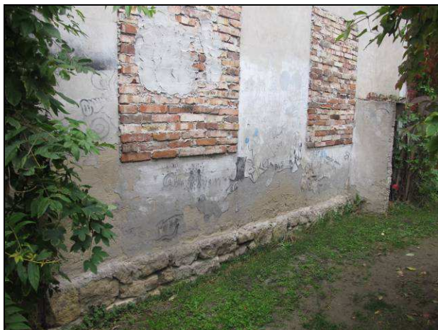
Foto č.5 – pohled na dvorní fasádu s kamenným základem, výskyt vlhkostních map se sprašováním
