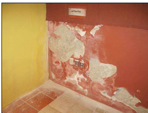
Foto č.10 – vysoká degradace omítek v prostoru sálu
