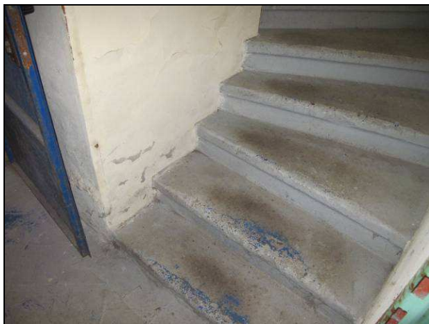
Foto č.11 – pohled na vstupní schodiště do 1.NP s vlhkostními projevy na omítkách
