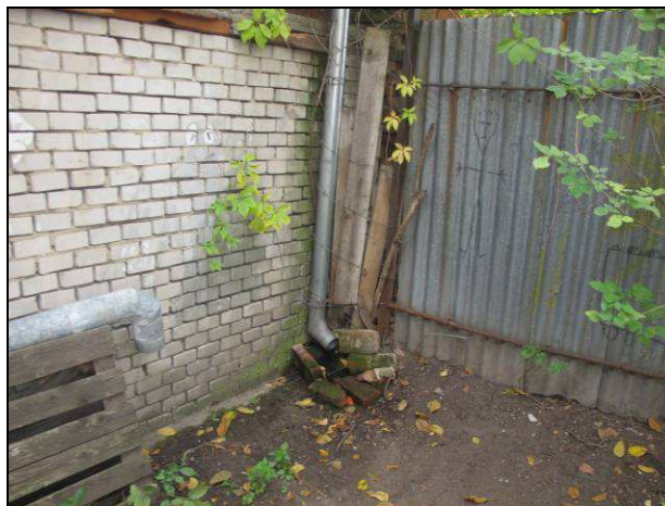
Foto č.6 – pohled na dešťový svod bez lapače splavenin, vyústění dešťového svodu na terén
